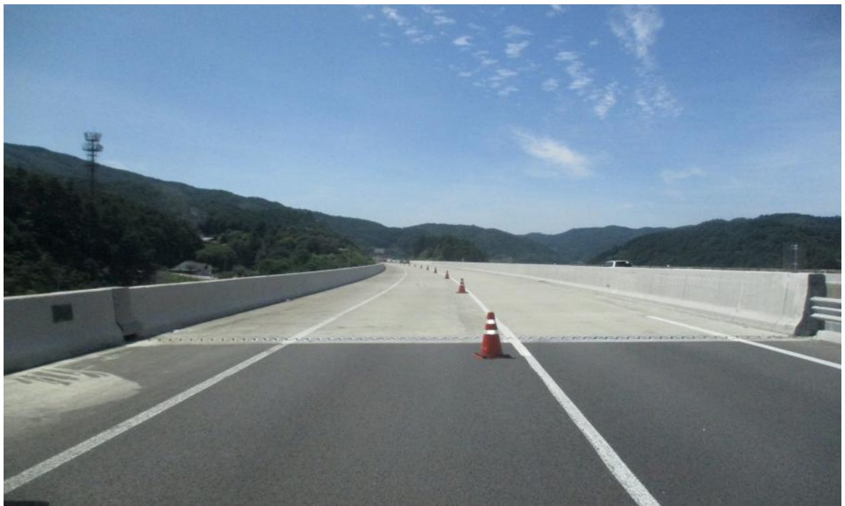
교량 상부 전경
