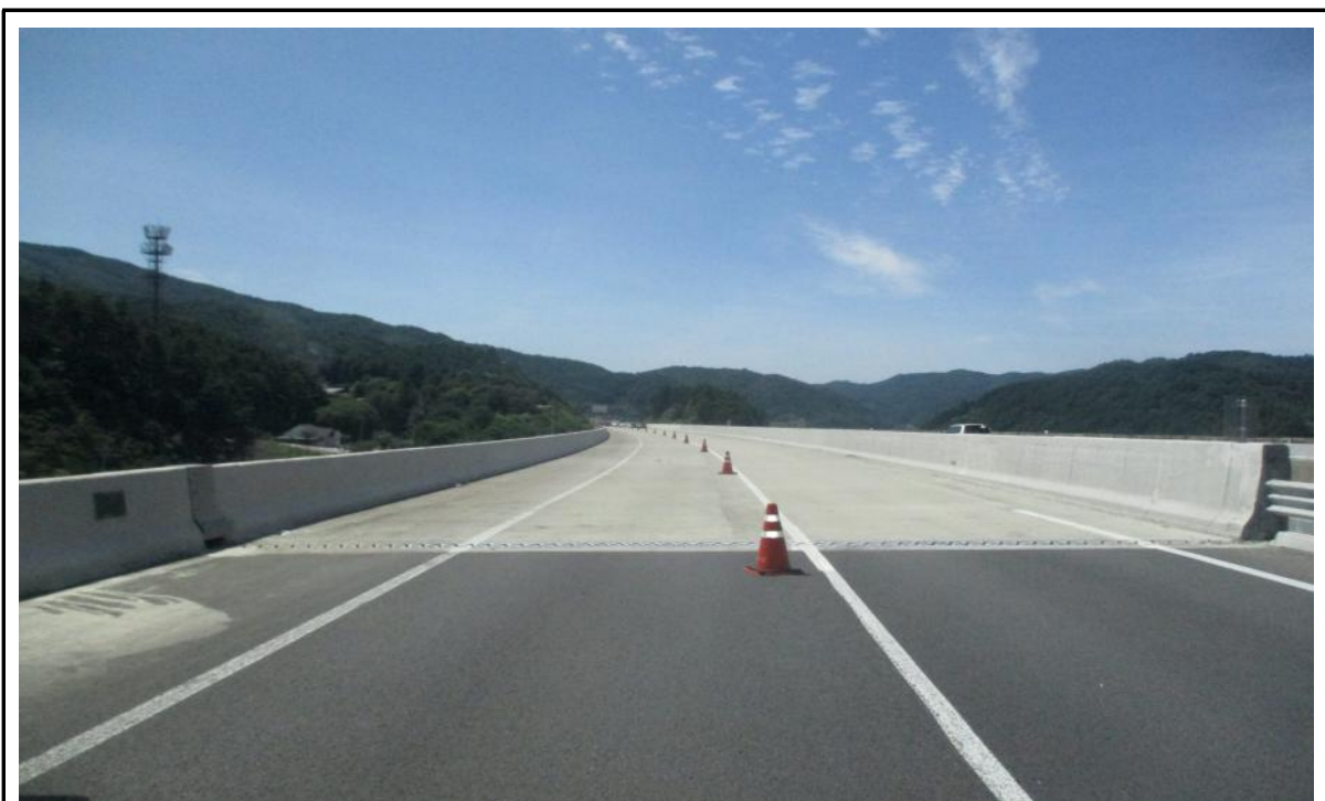
교량 상부 전경
